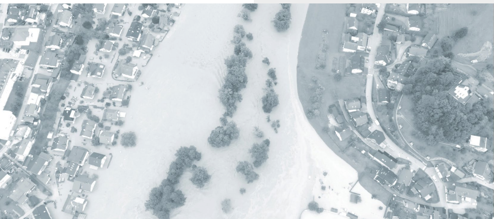
Uničujoče poplave so 4. avgusta 2023 močno prizadele Škofjo Loko. Posledice poplav so bile katastrofalne, saj je bilo poplavljenih približno 400 hiš, uničilo je cestno infrastrukturo in poškodovalo vodovodno, električno in telekomunikacijsko omrežje. (Avtor fotografije: Mitja Legat)
